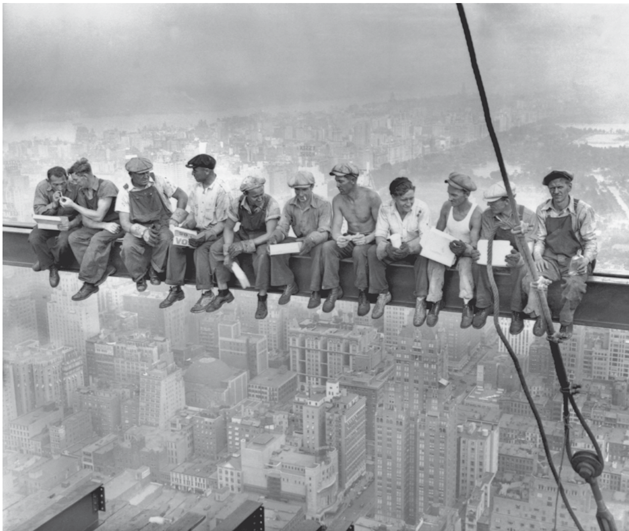
Trabajadores de la construcción de Nueva York almorzando sobre una viga, Charles Clyde Ebbets, 1932. © Bettmann/CORBIS
